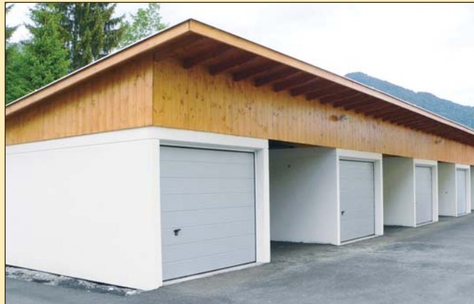
Garagenanlage mit Carport
