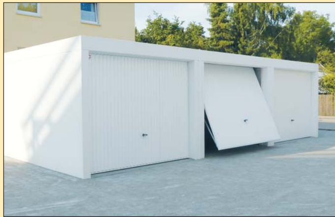
Reihengaragen mit Stahlschwingtoren
