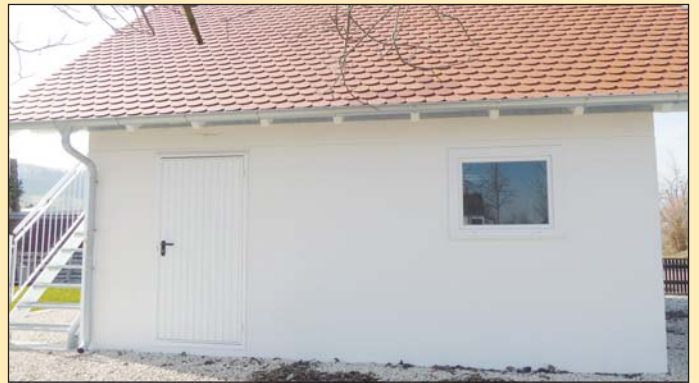
Fertigarage mit Tür und Fenster
